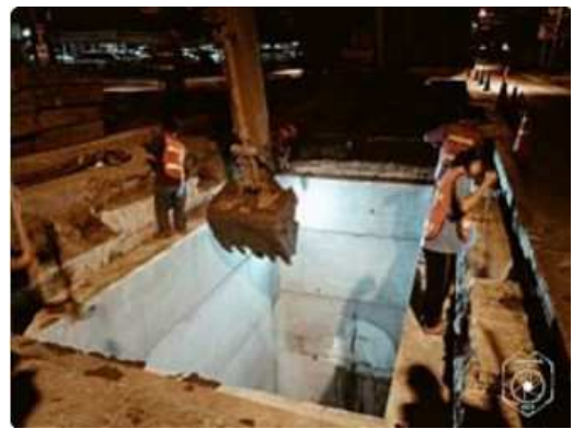
รูปที่ ๔ การติดตั้งชิ้นส่วนบ่อต้น-บ่อรับท่อใต้ดิน
