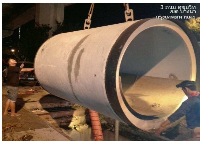
รูปที่ ๘ ท่อตัน (Jacking Pipe)
