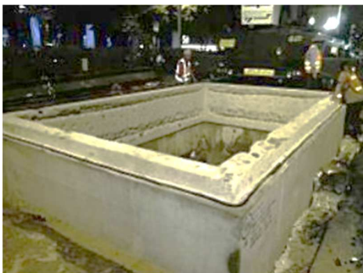
รูปที่ ๔ การติดตั้งชิ้นส่วนบ่อต้น-บ่อรับท่อใต้ดิน
