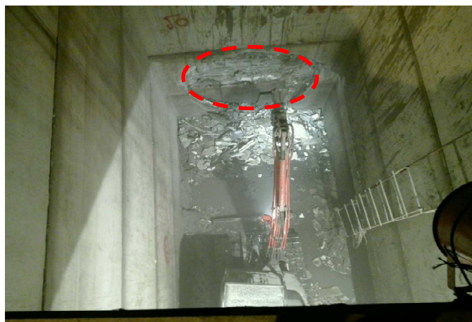
รูปที่ ๖ “Soft Eye”จุดซึ่งหัวเจาะจะต้องเจาะผ่านออกจากบ่อตัน หรือเจาะผ่านเข้าไปในบ่อรับ
