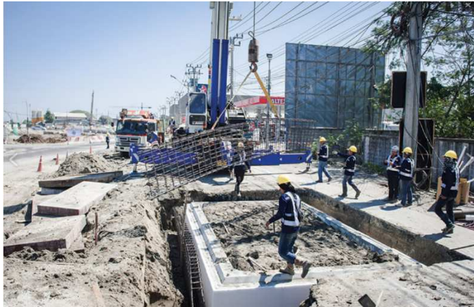
รูปที่ ๕ การติดตั้ง guide collar รอบบ่อตัน-บ่อรับ
