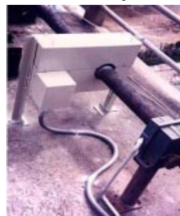
รูปแสดงเครื่องวัด เปิด-ปิดประตูระบายน้ำ แบบใช้เฟืองจับกับ แกนเพลลา
