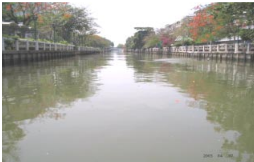
การปรับปรุงคลองระบายน้ำ
