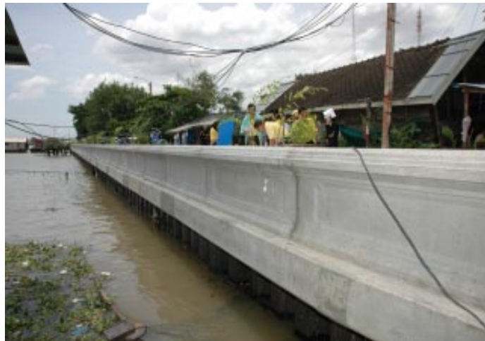
ภาพเขื่อนป้องกันน้ำท่วมริมแม่น้ำเจ้าพระยา
