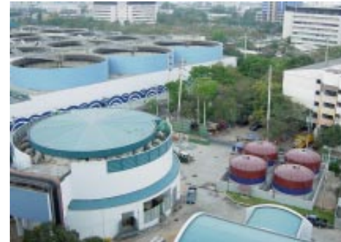
โรงควบคุมคุณภาพน้ำดินแดง
