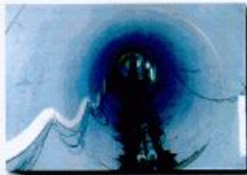
อุโมงค์ระบายน้ำพญาไท ช่วงลดคลองประปา เกล็ดขมิ้วด้วยเหล็ก
