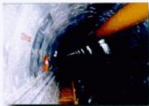
อุโมงค์ระบายน้ำคลองเปรมประชากร
