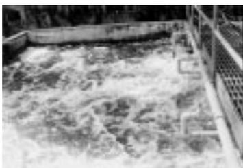
ภาพที่ 2 Aerobic Digestion Tank
