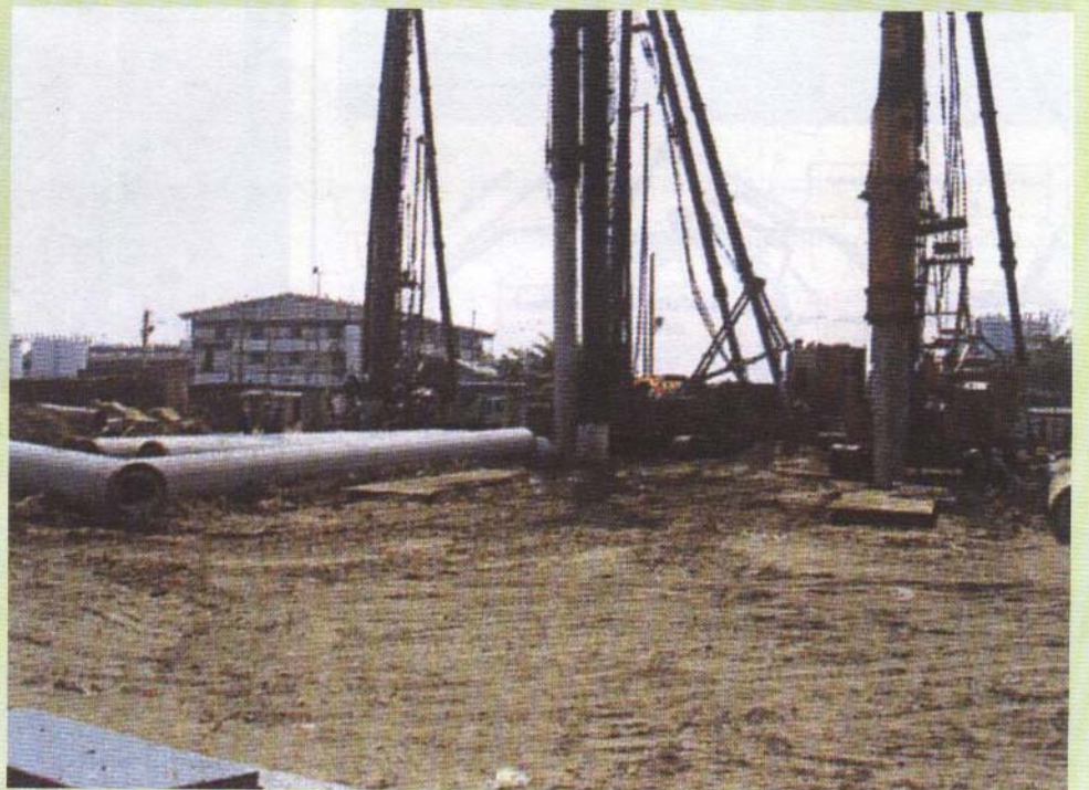
ก่อสร้างปล่องอุโมงค์สถานีสูบน้ำคลองขุดวัดช่องลม
