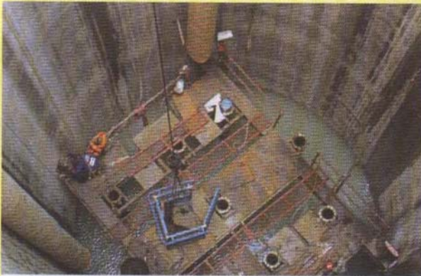
ก่อสร้างปล่องอุโมงค์สถานีสูบน้ำคลองขุดวัดช่องลม
