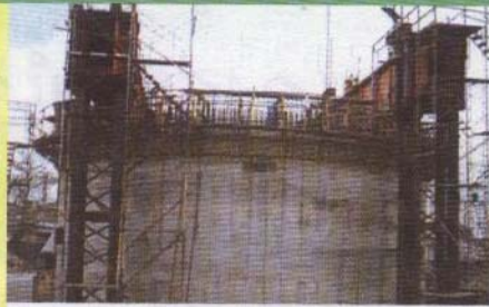
ก่อสร้างปล่องอุโมงค์อาคารระบายน้ำบริเวณถนนเชื้อเพลิง
