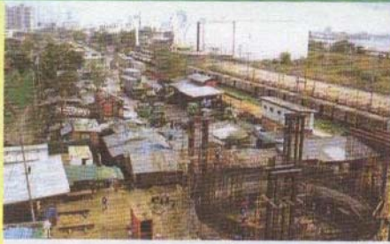
ก่อสร้างปล่องอุโมงค์สถานีสูบน้ำคลองขุดวัดช่องลม
