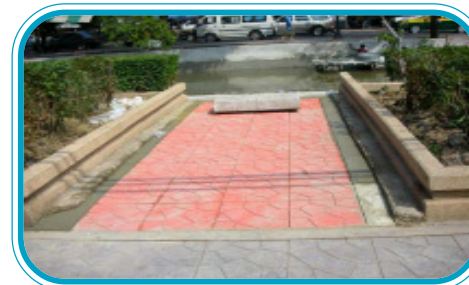
ทางเท้าที่ปรับปรุงเสร็จแล้ว
