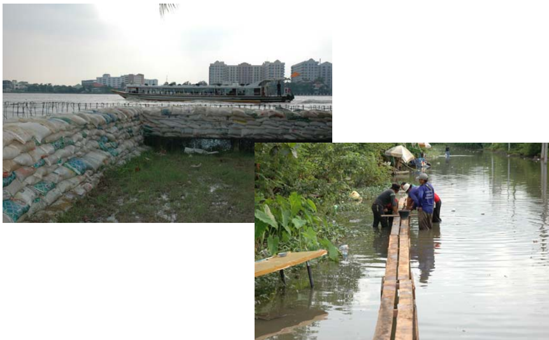
ภาพการสร้างแนวป้องกันชั่วคราวและการสร้างทางเดินไม้เพื่อช่วยเหลือประชาชน
