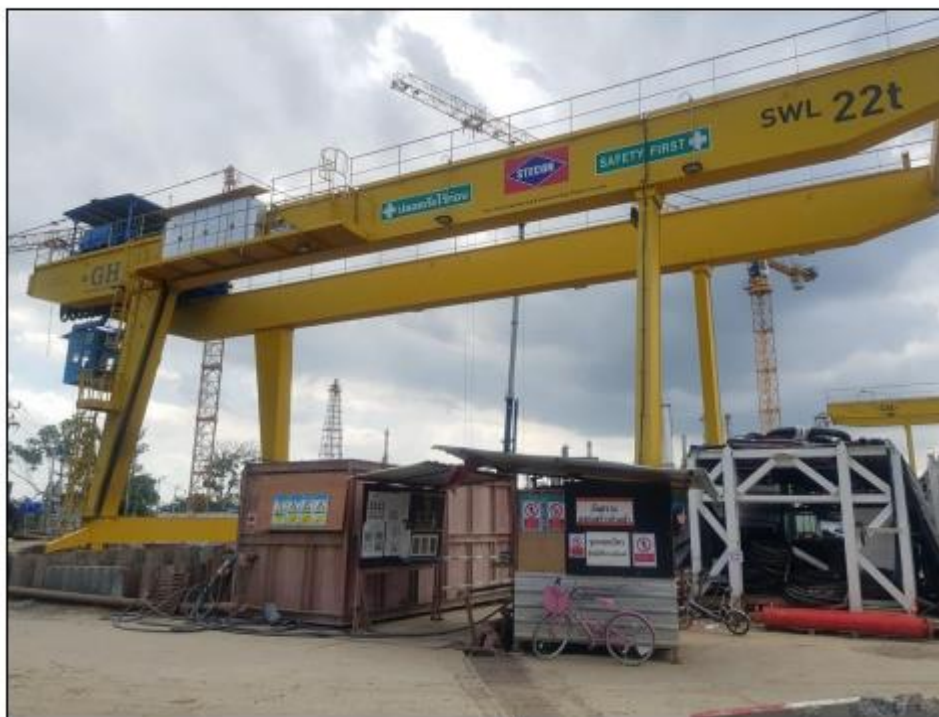
รูปที่ ๒๒ แสดง Gantry Crane สำหรับยกชิ้นส่วนอุโมงค์และลำเลียงดินออกจากอุโมงค์
