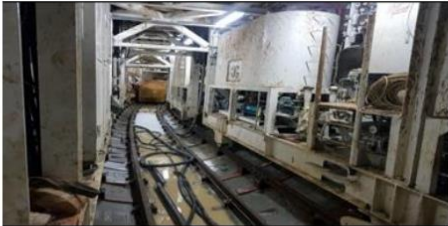
รูปที่ ๒๕ แสดงอุปกรณ์ช่วยส่วนท้าย (Backup Unit)
