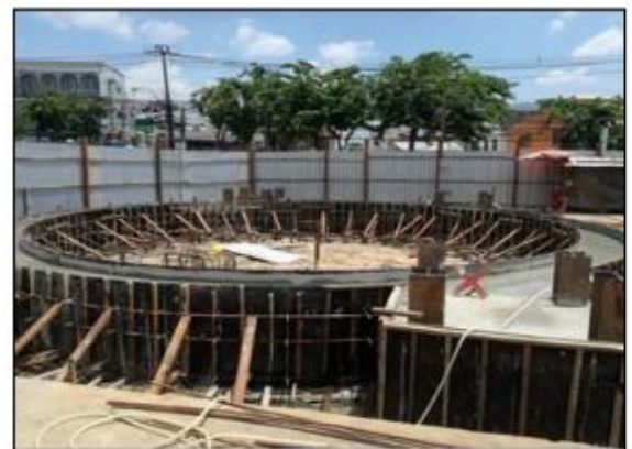
รูปที่ ๓ แสดงเหล็กเสริม RC Ring Beam และ เทคอนกรีต RC Ring Beam
