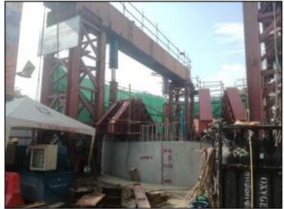
รูปที่ ๑๓ แสดงการติดตั้งโครงสร้างหยุดการจม (Stopped Sinking Structure)
