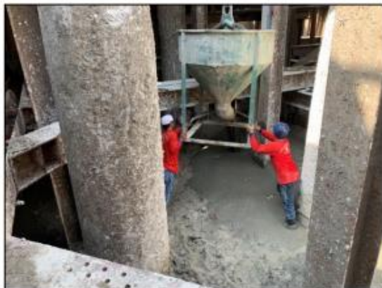
รูปที่ ๒๖ แสดงการเท Lean Concrete ที่ระดับห้อง Base Slab
