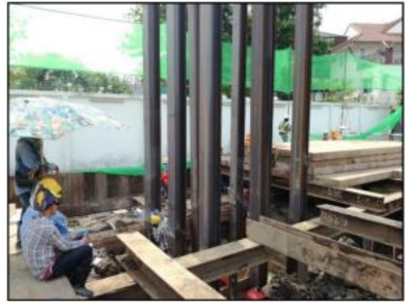
รูปที่ ๒ แสดงการกด King post เพื่อเป็นเสาเข็มรองรับ RC Ring Beam และ เสาเข็มเสมอ (Anchor Pile)
