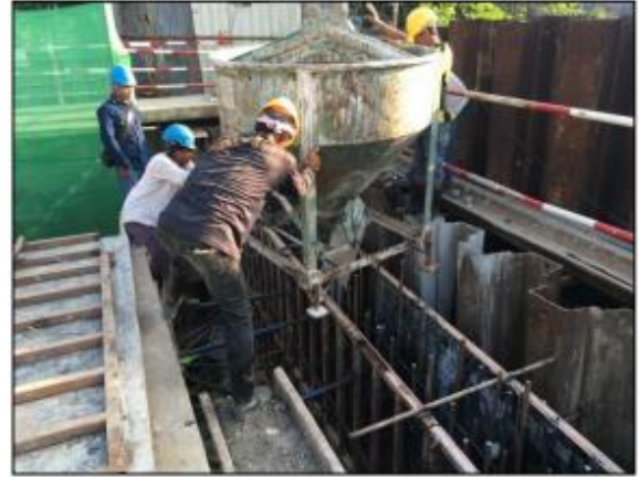
รูปที่ ๓๕ แสดงการติดตั้งเหล็กเสริมและเทคอนกรีตผนังอาคารชั้นที่ ๒
