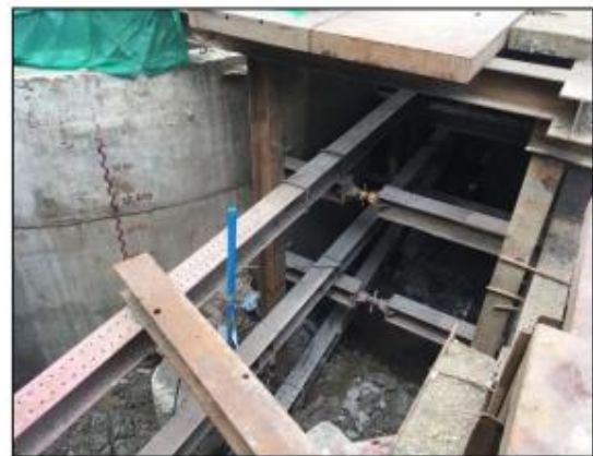
รูปที่ ๒๕ แสดงการติดตั้งระบบค้ำยันชั้นที่ ๓
