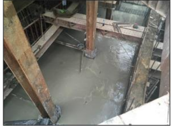
รูปที่ ๓๓ แสดงการทดสอบ Slump Test และการเทคอนกรีต Base Slab
