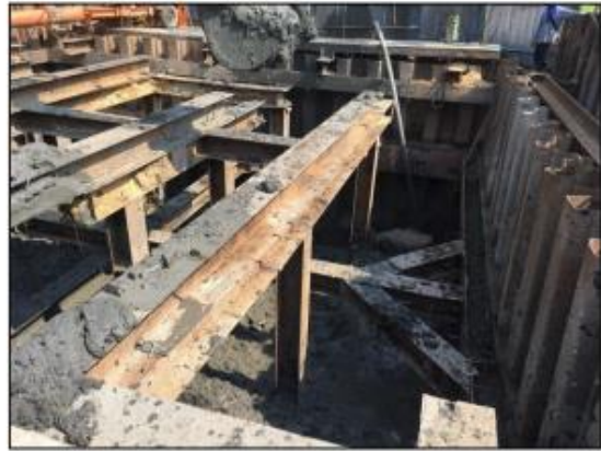
รูปที่ ๒๔ แสดงการติดตั้งระบบค้ำยันชั้นที่ ๒
