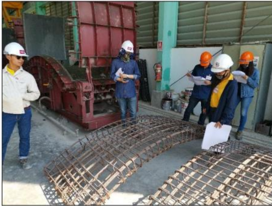
รูปที่ ๑๒ การตรวจสอบจำนวนเหล็กเสริมก่อนนำลงโมลหล่อชิ้นส่วน
