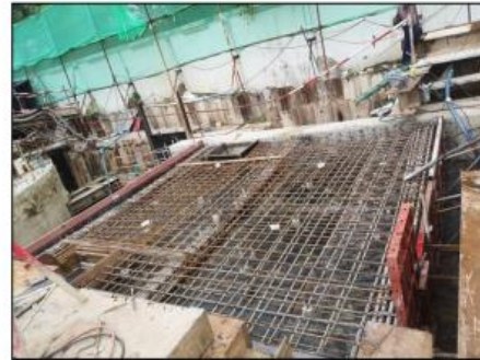
รูปที่ ๓๗ แสดงการติดตั้งเหล็กเสริมและแบบหล่อคอนกรีตคานและพื้นอาคาร
