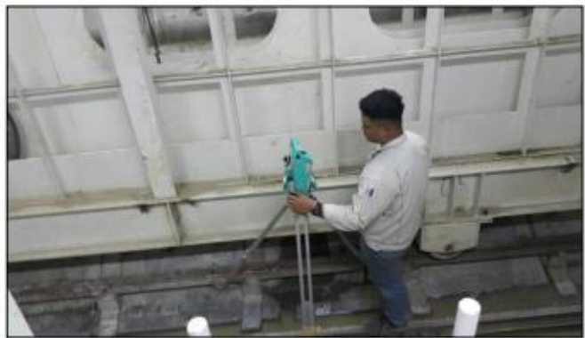
รูปที่ ๒๗ แสดงระบบ Guidance System และงานสำรวจภายในอุโมงค์
