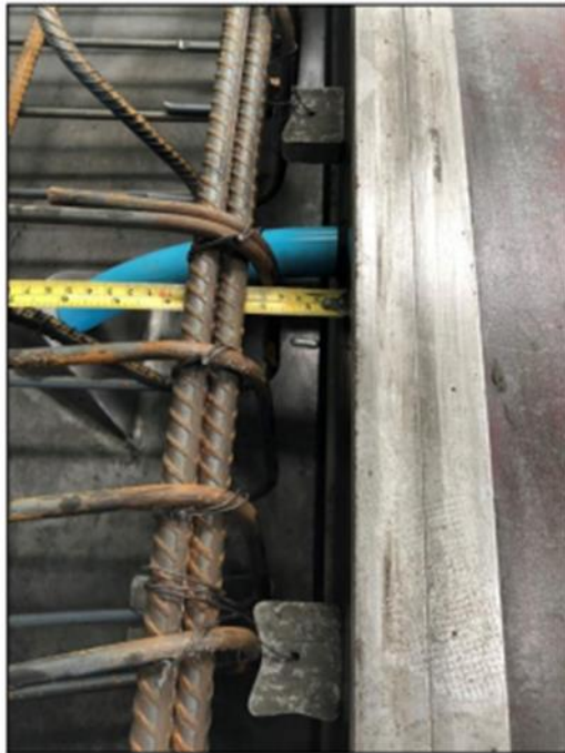
รูปที่ ๑๔ แสดงการตรวจสอบระยะหุ้มคอนกรีต
