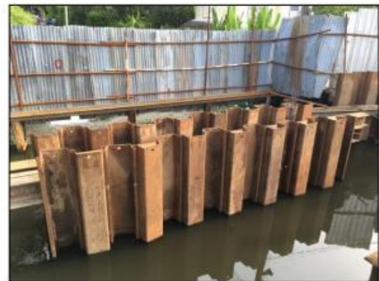
รูปที่ ๒๑ แสดงการกัด Sheet Pile และ Coffer Dam โดยใช้ Vibro Hammer
