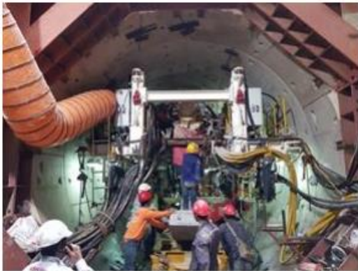
รูปที่ ๓๐ การขุดเจาะช่วง Initial Drive ๑๐๐ - ๑๒๐ เมตร
