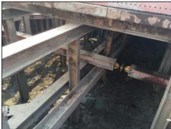
รูปที่ ๒๓ แสดงการติดตั้งระบบค้ำยันชั้นที่ ๑
