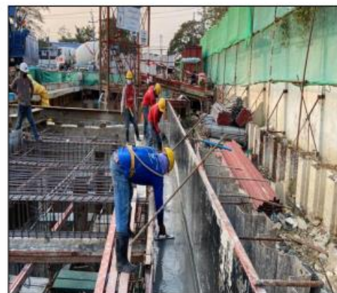
รูปที่ ๓๖ แสดงการติดตั้งเหล็กเสริมและเทคอนกรีตผนังอาคารชั้นที่ ๓
