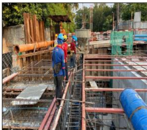
รูปที่ ๓๖ แสดงการติดตั้งเหล็กเสริมและเทคอนกรีตผนังอาคารชั้นที่ ๓
