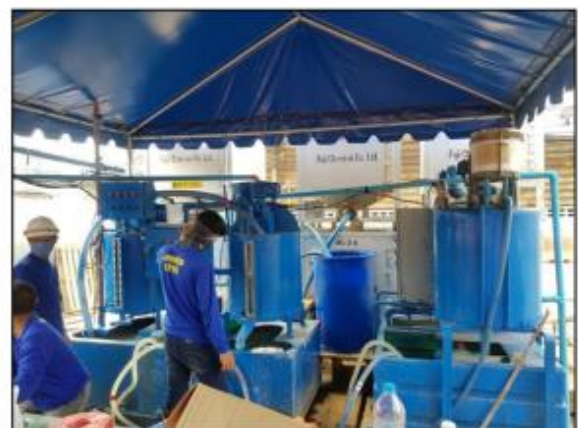
รูปที่ ๒๘ แสดงงานปรับปรุงคุณภาพดินหน้า Soft Eye
