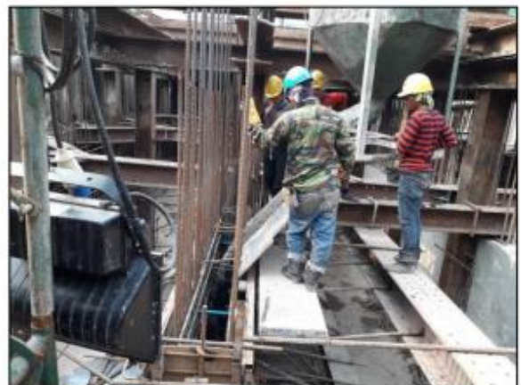
รูปที่ ๓๔ แสดงการติดตั้งเหล็กเสริมและเทคอนกรีตผนังอาคารชั้นที่ ๑
