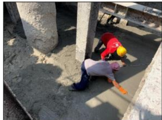
รูปที่ ๒๖ แสดงการเท Lean Concrete ที่ระดับห้อง Base Slab
