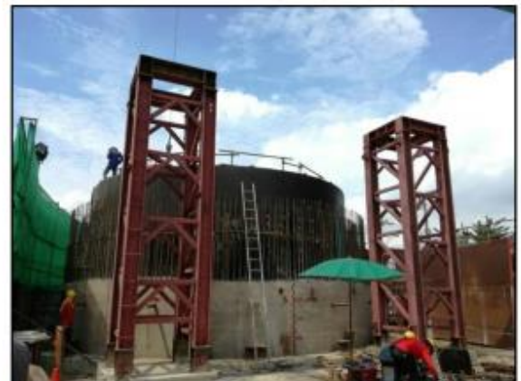
รูปที่ ๔ แสดงการติดตั้ง Steel Tower Support
