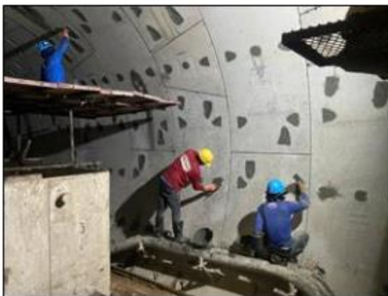
รูปที่ ๓๔ แสดงงาน Infill ของ Bolt pocket
