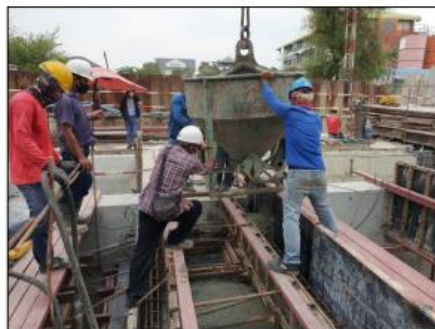
รูป ๓๘ แสดงการเทคอนกรีตคานและพื้นอาคาร
