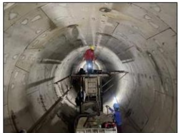
รูปที่ ๓๔ แสดงงาน Infill ของ Bolt pocket
