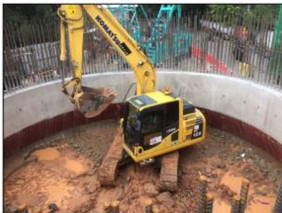
รูปที่ ๑๐ แสดงการขุดดินภายในปล่องอุโมงค์ เพื่อจมปล่อง และตอกสลักไม้เพื่อชะลอการจม
