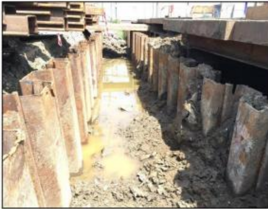
รูปที่ ๒๒ แสดงถมดินภายใน Sheet Pile และ Cofferdam ในพื้นที่ก่อสร้าง
