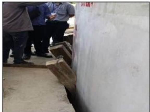
รูปที่ ๑๐ แสดงการขุดดินภายในปล่องอุโมงค์ เพื่อจมปล่อง และตอกสลักไม้เพื่อชะลอการจม
