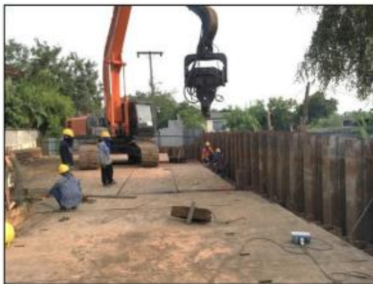
รูปที่ ๒๑ แสดงการกัด Sheet Pile และ Coffer Dam โดยใช้ Vibro Hammer
