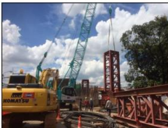
รูปที่ ๔ แสดงการติดตั้ง Steel Tower Support
