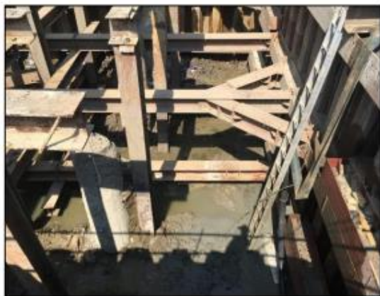
รูปที่ ๒๕ แสดงการติดตั้งระบบค้ำยันชั้นที่ ๓
