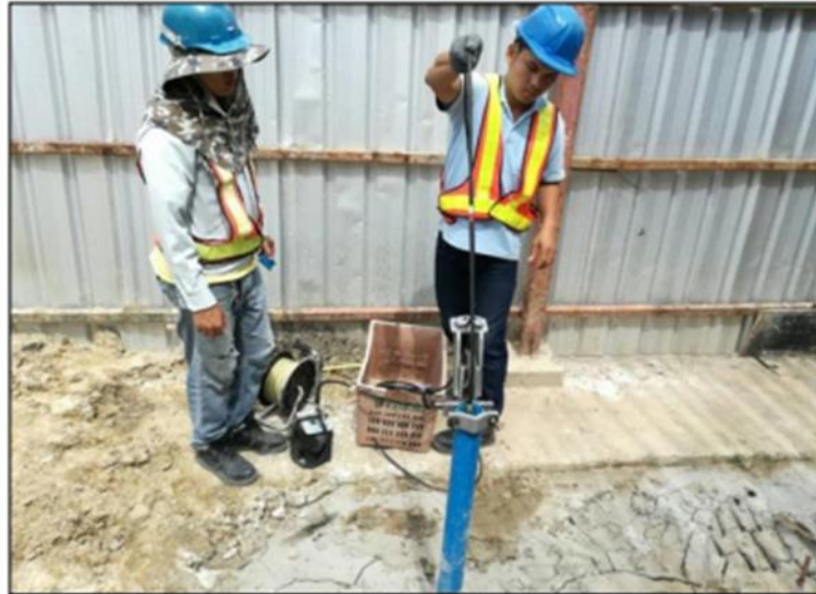
รูปที่ ๑๗ แสดงการตรวจวัดค่าการเคลื่อนตัวด้านข้าง (Inclinometer)
