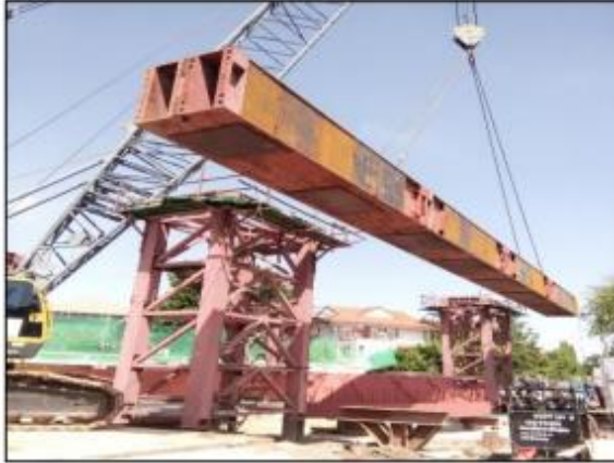
รูปที่ ๕ แสดงการติดตั้ง Jacking Beam และกระบอก Hydraulic Jack
