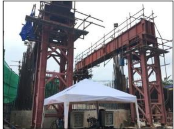
รูปที่ ๕ แสดงการติดตั้ง Jacking Beam และกระบอก Hydraulic Jack
