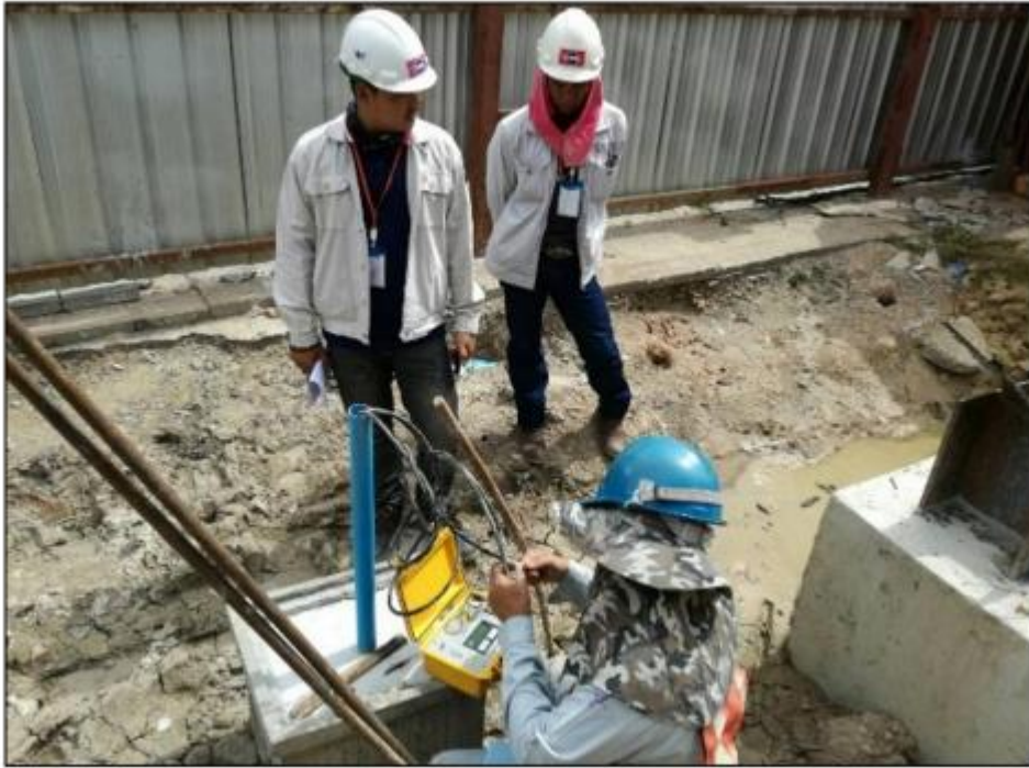
รูปที่ ๑๙ การตรวจวัดค่าแรงดันน้ำใต้ดิน (Piezometer)
