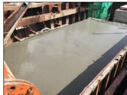
รูป ๓๘ แสดงการเทคอนกรีตคานและพื้นอาคาร
