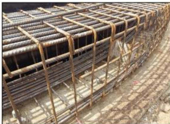
รูปที่ ๓ แสดงเหล็กเสริม RC Ring Beam และ เทคอนกรีต RC Ring Beam
