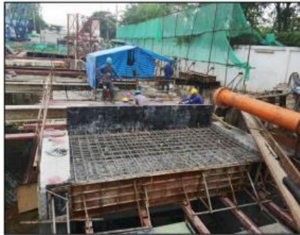
รูปที่ ๓๗ แสดงการติดตั้งเหล็กเสริมและแบบหล่อคอนกรีตคานและพื้นอาคาร
