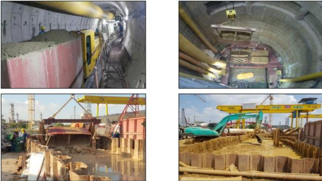
รูปที่ ๓๒ แสดงการขนย้ายและลำเลียงดินออกจากอุโมงค์
