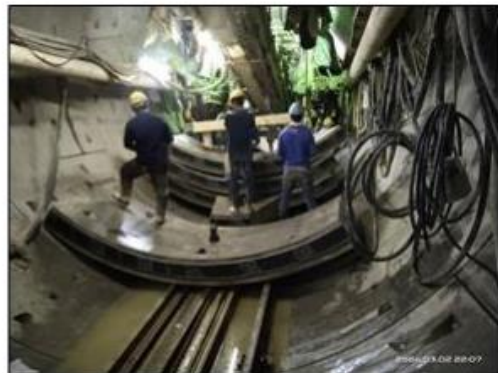
รูปที่ ๓๑ การขุดเจาะช่วง Main Drive
