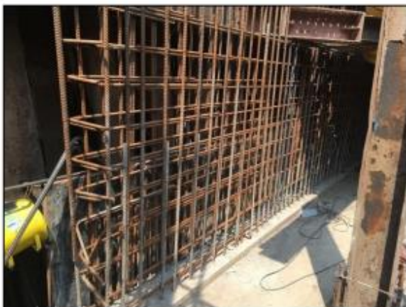
รูปที่ ๓๔ แสดงการติดตั้งเหล็กเสริมและเทคอนกรีตผนังอาคารชั้นที่ ๑
