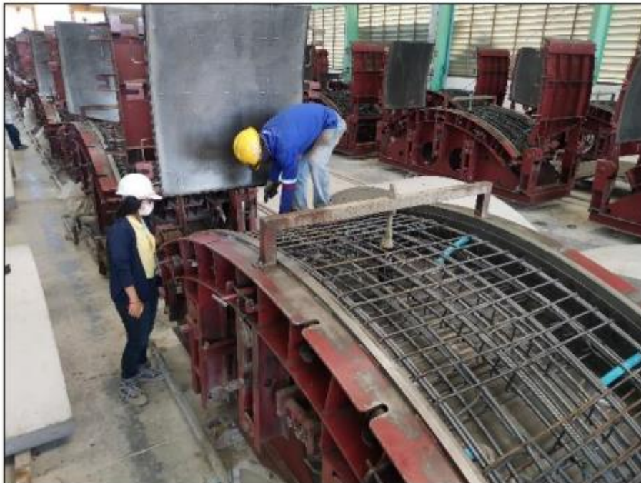
รูปที่ ๑๓ แสดงการตรวจสอบขนาดเหล็กเสริม และระยะหุ้มคอนกรีต
