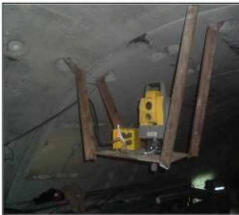
รูปที่ ๒๗ แสดงระบบ Guidance System และงานสำรวจภายในอุโมงค์
