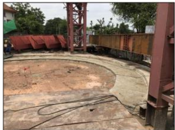
รูปที่ ๖ แสดงการปรับพื้นที่ โดยการบดอัดดิน ทดสอบการรับน้ำหนักบรรทุกทุกของพื้นดิน โดยวิธี Plate Bearing และเทคอนกรีตหยาบ
