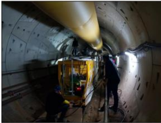
รูปที่ ๓๓ แสดงงานอุดช่องว่างรอบ Segment (Primary and Secondary Grouting)
