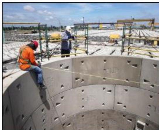
รูปที่ ๒๐ การวัดความหนาแน่นโดยการประกอบ Ring No.๑ และ No.๒ เข้าด้วยกัน
