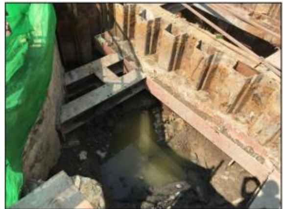
รูปที่ ๒๓ แสดงการติดตั้งระบบค้ำยันชั้นที่ ๑
