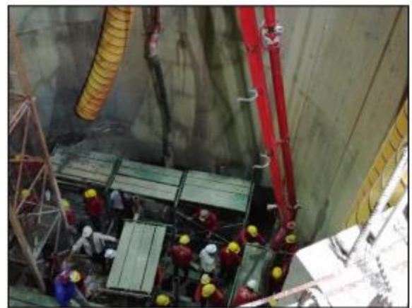
รูปที่ ๑๔ แสดงการเทคอนกรีตอุดกันปล่องอุโมงค์ (Concrete Plug) เพื่อป้องกันน้ำใต้ดินเข้ามาในปล่อง
