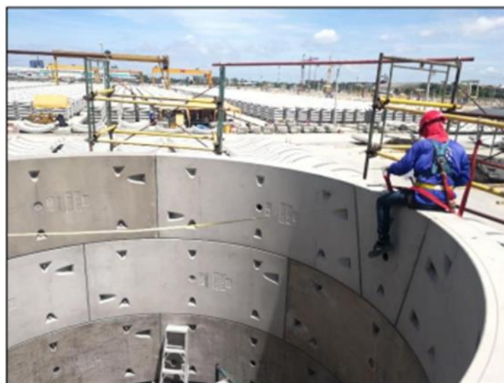
รูปที่ ๑๙ การวัดความคลาดเคลื่อนเส้นผ่านศูนย์กลางโดยการประกอบ Ring Assembly
