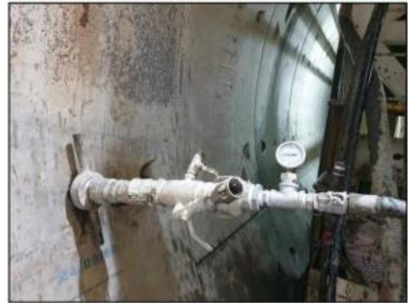
รูปที่ ๓๓ แสดงงานอุดช่องว่างรอบ Segment (Primary and Secondary Grouting)
