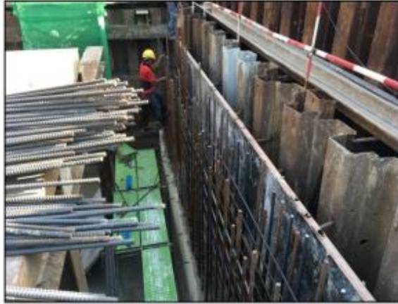
รูปที่ ๓๕ แสดงการติดตั้งเหล็กเสริมและเทคอนกรีตผนังอาคารชั้นที่ ๒
