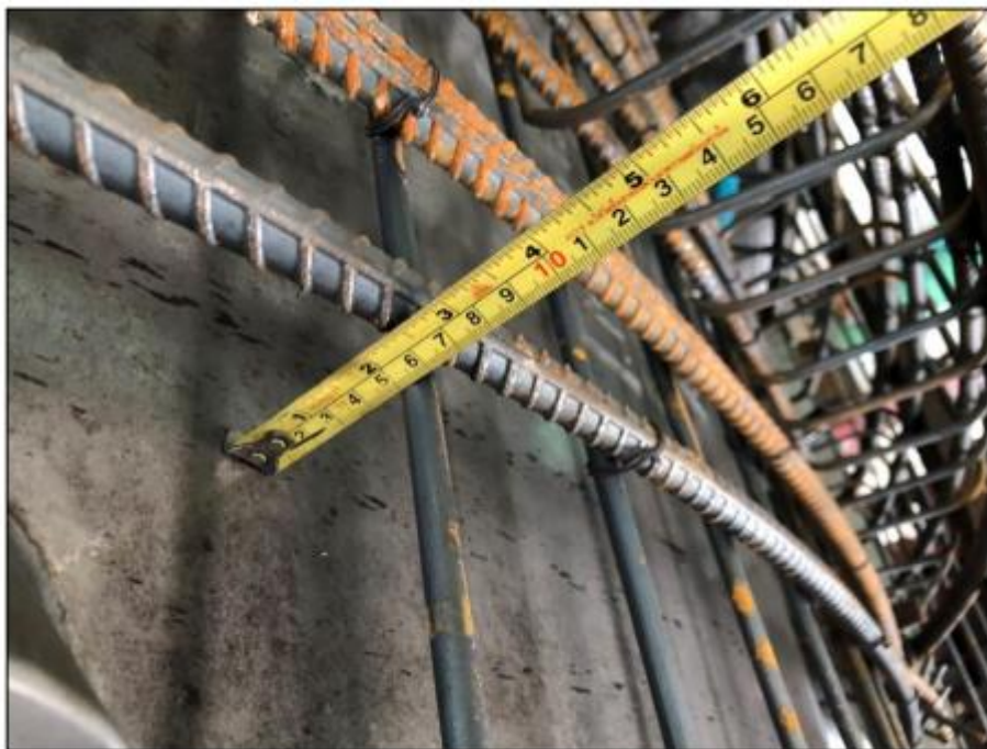
รูปที่ ๑๔ แสดงการตรวจสอบระยะหุ้มคอนกรีต
