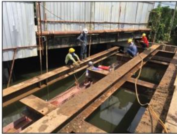
รูปที่ ๒๐ แสดงการติดตั้งโครงสร้าง Temporary Platform
