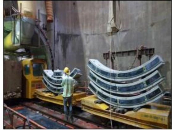
รูปที่ ๒๙ แสดงการขนส่งชิ้นส่วนอุโมงค์จากโรงงานผลิต และการขนส่งภายในอุโมงค์
