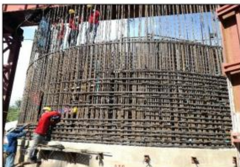
รูปที่ ๑๒ แสดงการผูกเหล็กเข้าแบบผนังชั้นต่อไปและการกดจมปล่องอุโมงค์ด้วยแม่แรงไฮดรอลิก
