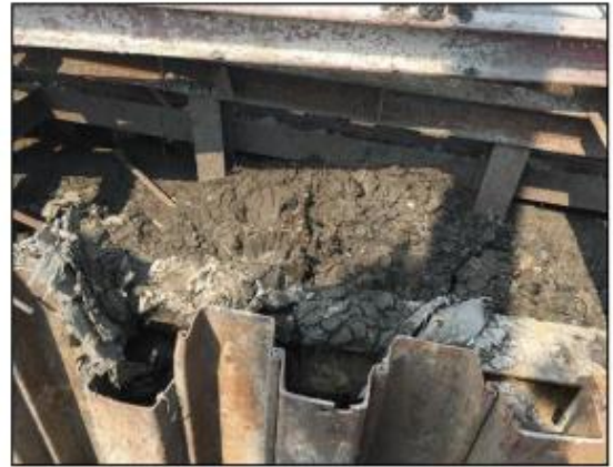
รูปที่ ๒๒ แสดงถมดินภายใน Sheet Pile และ Cofferdam ในพื้นที่ก่อสร้าง
