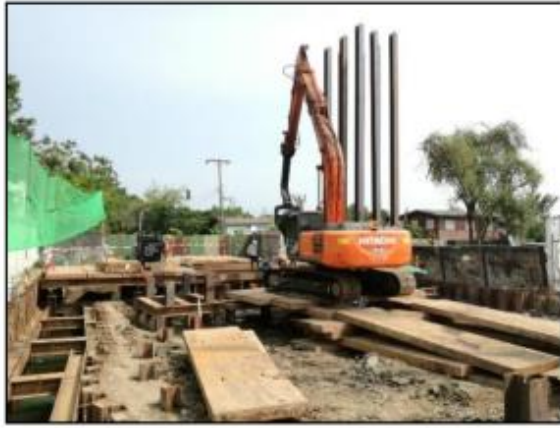
รูปที่ ๒ แสดงการกด King post เพื่อเป็นเสาเข็มรองรับ RC Ring Beam และ เสาเข็มเสมอ (Anchor Pile)
