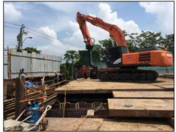
รูปที่ ๒๐ แสดงการติดตั้งโครงสร้าง Temporary Platform
