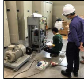
ภาพที่ ๘ ทดสอบการทำงาน Air Circuit Breaker
