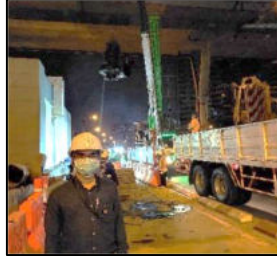
ภาพที่ ๗ ติดตั้งเครื่องสูบน้ำไฟฟ้า สถานีสูบน้ำพระราม ๓
